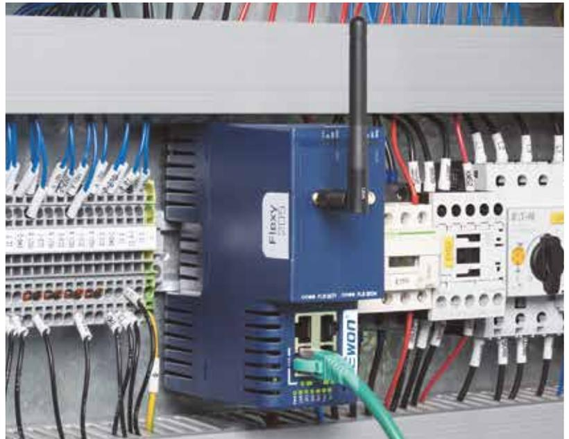
Kompakt und platzsparend findet der Router Platz im Schaltschrank der Maschine
